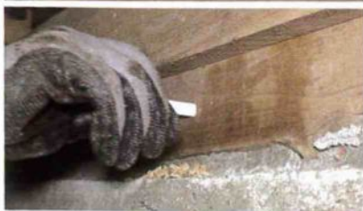
上/ホウ酸換算濃度24%の水溶液を噴霧。アメリカカンザイシロアリ対策 中/ホウ酸を含むシーリングでスリーブ管周囲の隙間を塞いでシロアリの侵入を防ぐ 下/ホウ酸を含むスティックを浴室土台に挿入した例。含水率が高くなる木材に挿入すると内部でホウ酸が広がる
